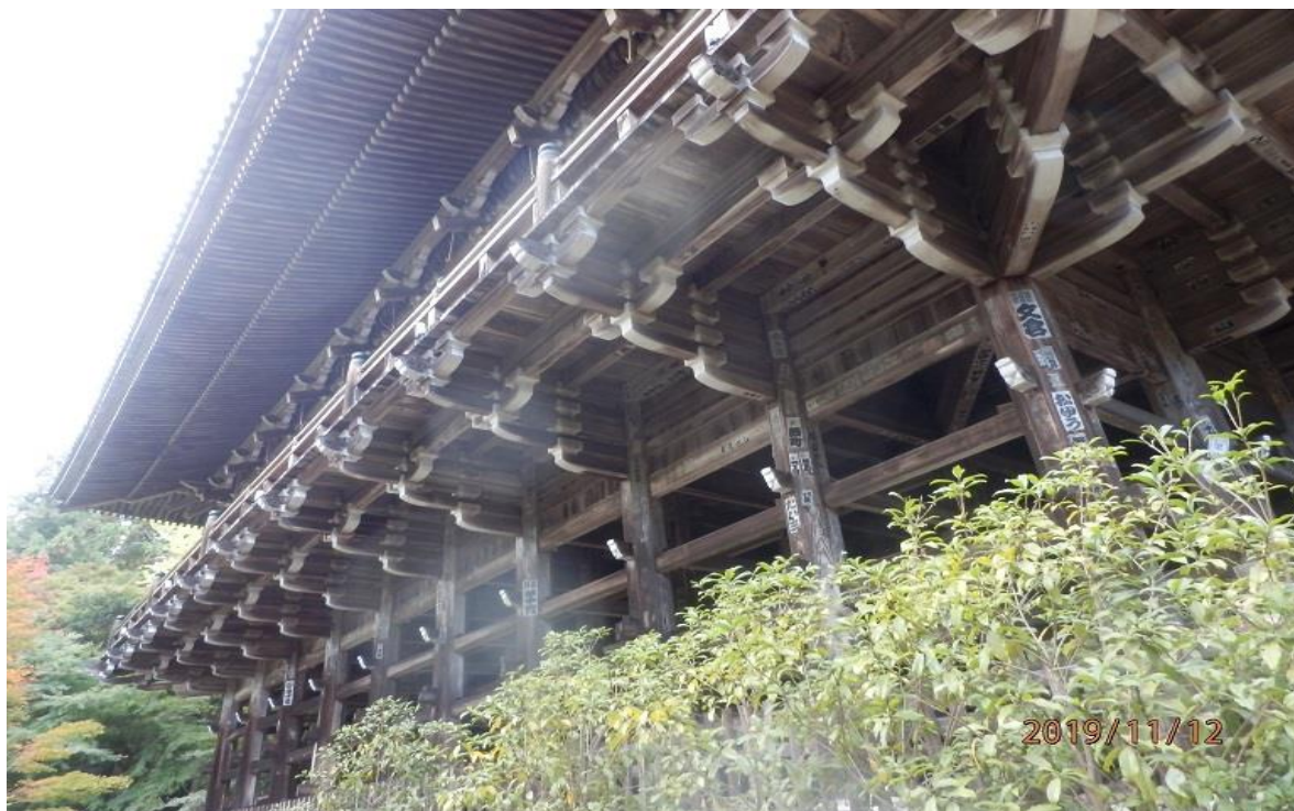
（観音堂[摩尼殿]の豪壮な懸造り。上部は京都清水寺と同じく舞台造りの回廊になっている）
