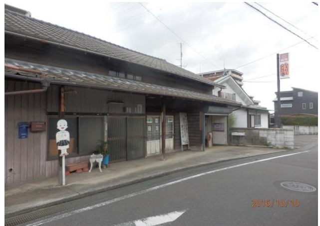
(建物の右端のガレージを遍路小屋に開放)
