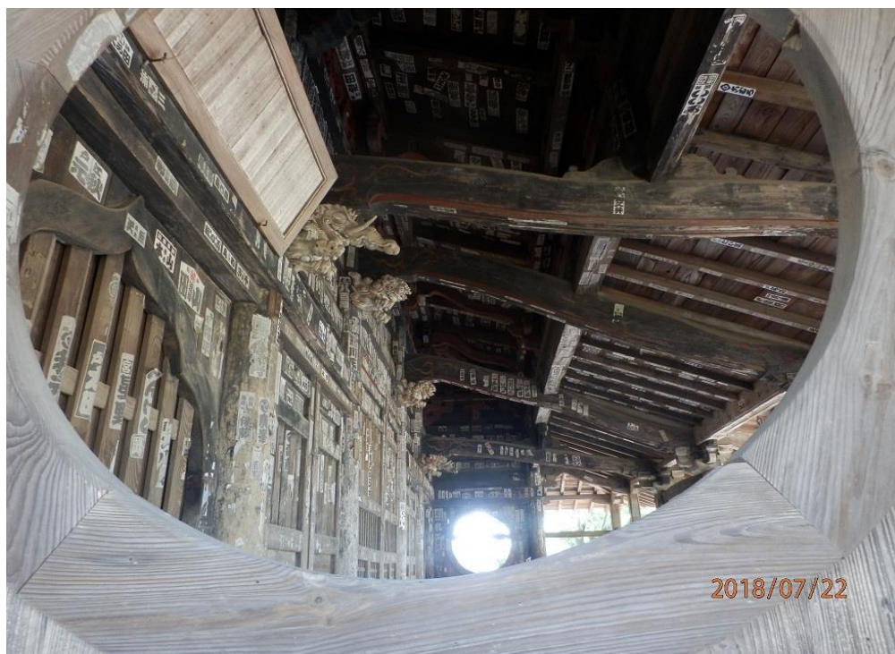
（観音堂外陣の丸窓と火頭窓（手前左側））
