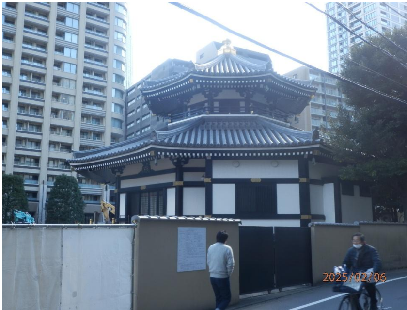
(工事用柵で囲まれ立ち入り禁止となっている天徳寺。2025年2月現在)
